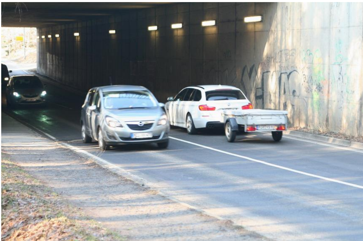
Autotunnel von Langebrück Richtung Klotzsche (70km/h); keine Radwege, einseitiger Fußweg
